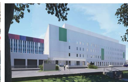
HUS Naistenklinikan peruskorjaus 25 000 brm 2 , 160 milj. €
